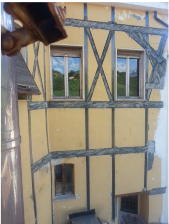
Messa in sicurezza con fibre di carbonio
