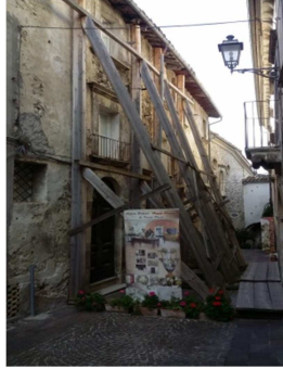
Cerchiature con strutture metalliche, puntellatura in legno, cerchiature con travetti in legno e tiranti o con ponteggi
