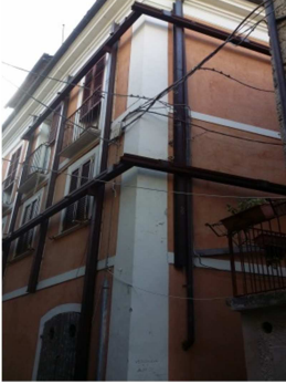
Cerchiature con strutture metalliche, puntellatura in legno, cerchiature con travetti in legno e tiranti o con ponteggi
