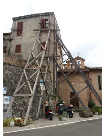
Cerchiature con strutture metalliche, puntellatura in legno, cerchiature con travetti in legno e tiranti o con ponteggi
