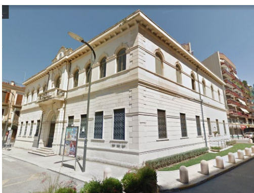
Edificio di Barletta, piazza dei Caduti
